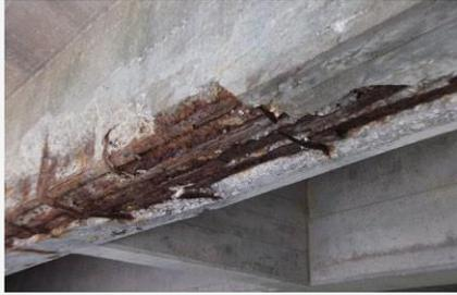
活躍腐蝕開始的熱點區域檢測涉及測量半電池電位（即腐蝕電位）的局部負值。在使用棒式電極時，使用者必須定義一個足夠細小且不會錯過任何局部最大負值的網格，而在新 Profometer Corrosion 上使用輪式電極可確保獲得更高的精度。輪式系統足
